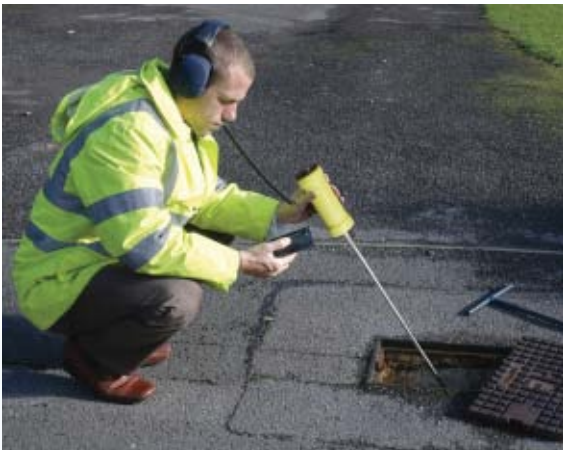
Utilisation du Leak Sizer pour une écoute directe des fuites
